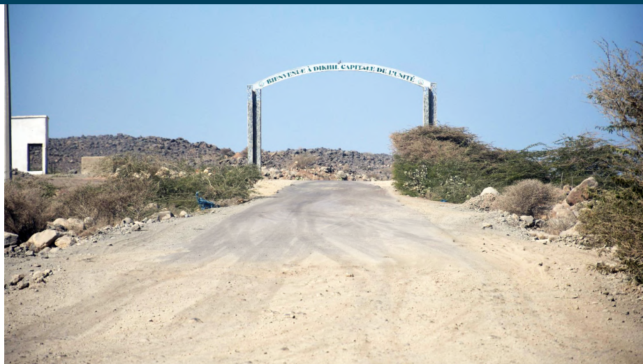
Crédit photo ADR, Tronçon Mouloud-Dikhil, 18Km
