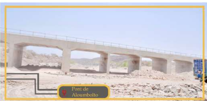
Projet RN1- Pont de Aloumbolto : Dikhil (Daguirou-Galamo, 60Km)
